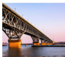
大型桥梁位移测量
